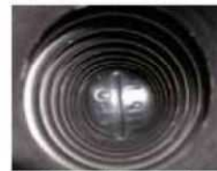
管内状況(漏水なし)
